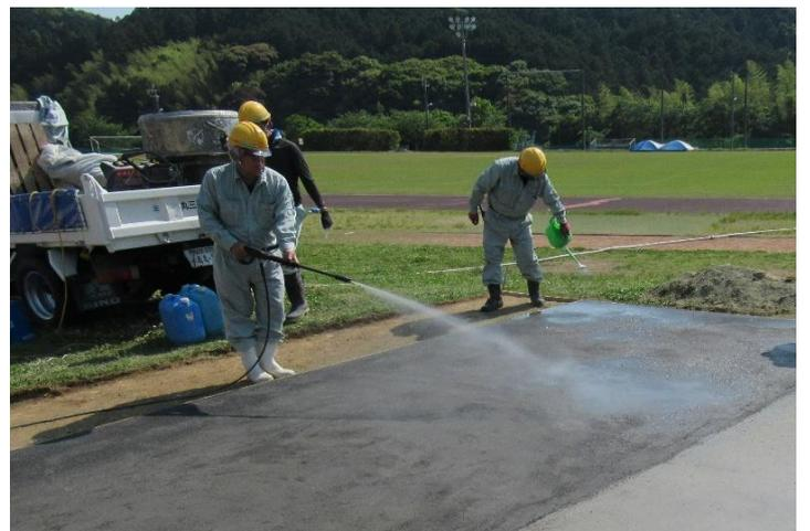
④表面の水光りが消えてから2次散水
