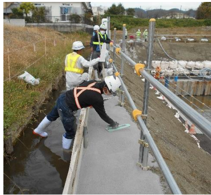
②敷均し (コテ等で均一に均す)
