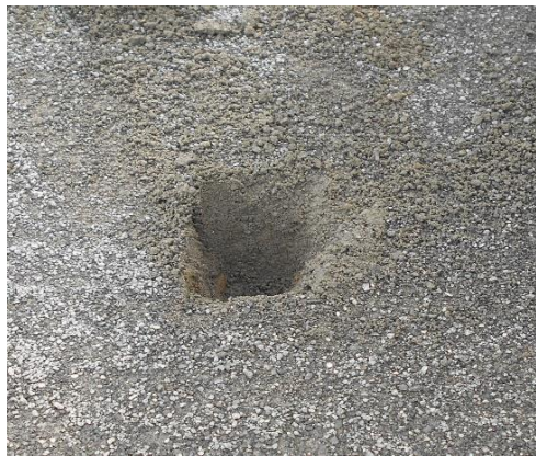
④適宜散水の浸透深さ確認 (厚さの3/4以上)
