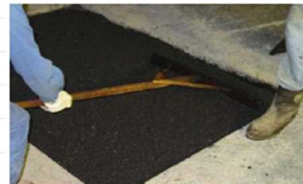
舗装応急復旧
