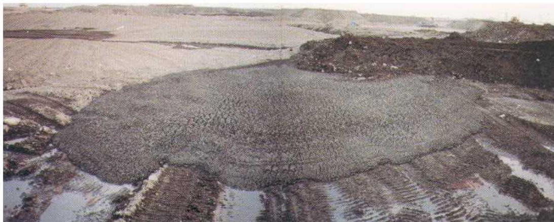
ボーリン グ孔から 噴出した 地盤内部 の汚泥
