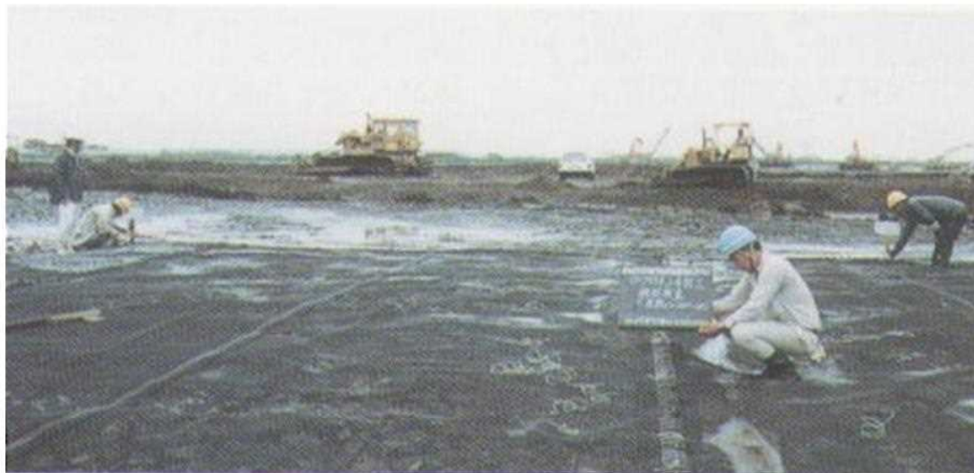
ネット敷 設後に作 業実施
