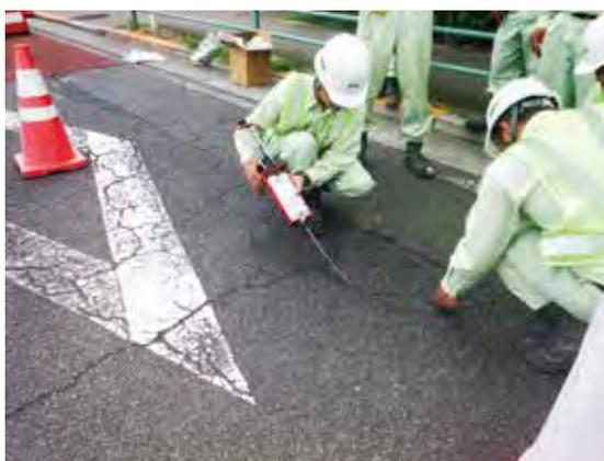
舗装のひび割れ補修には常温型補修材のFRフィラー、舗装の陥没個所や段差個所には柑橘系果皮オイルを配合し、人にも環境にも優しいオレンジパッチを取扱っております。
